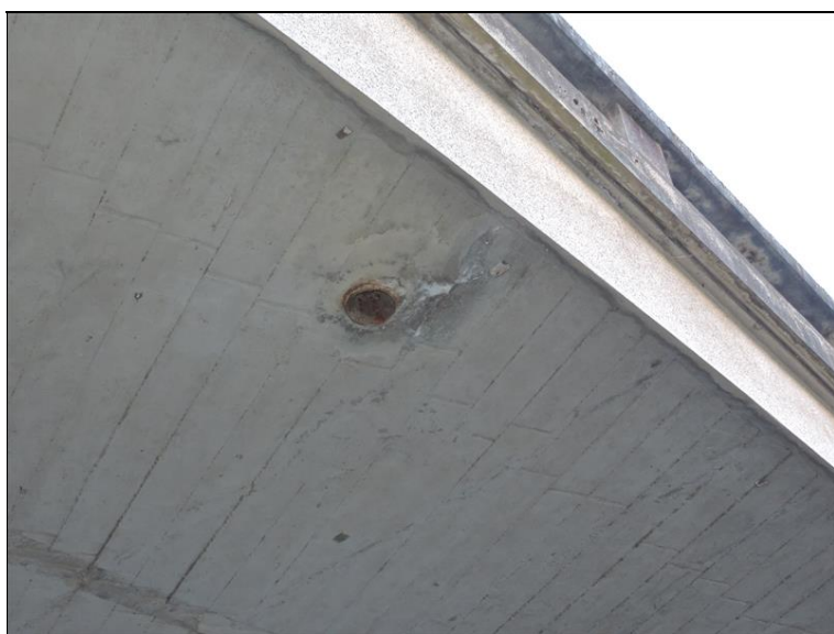
DSCN1780.JPG Zatékání kolem odvodňovače na LS, pole 2 u P3
