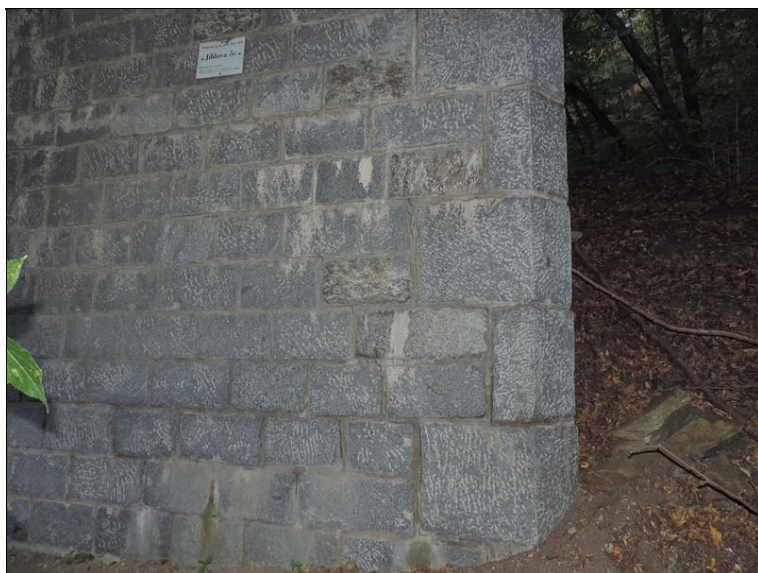
DSCN1765.JPG PS OP4 - trhliny ve sparách š. až 5 mm
