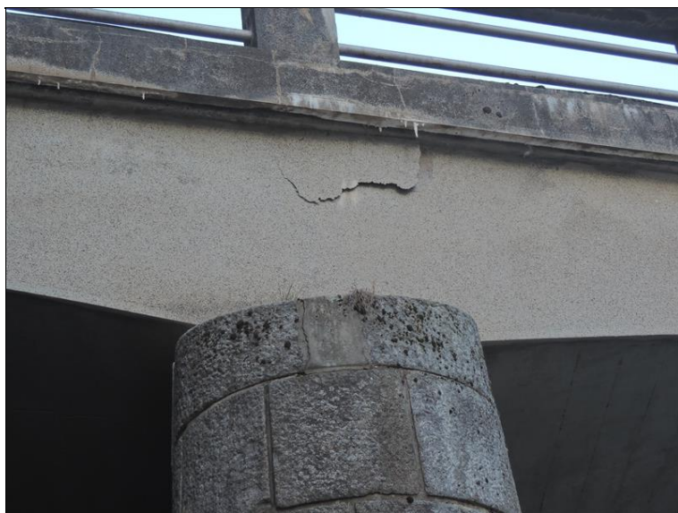
DSCN1777.JPG Výluhy s krápníky a opadaná krycí vrstva nad pilířem č. 3 na LS
